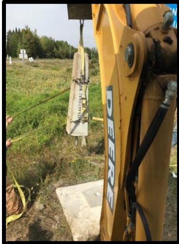
Figure 2- Mise en place de l'obélisque à l'aide d'une rétro caveuse (ME/NB)
