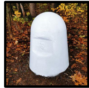
Figure 12 – RM 5-41, une borne typique en forme de cloche (NY/ON)
