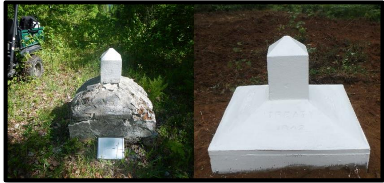
Figure 3- (À gauche) Mon 1B rétablie et (à droite) Mon 1B après le renouvellement (ME/NB)
