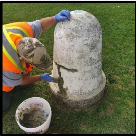
Figure 10 – Daniel Laviolette répare une borne en forme de cloche (NY/ON)
