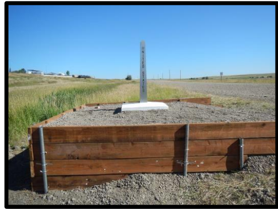
Figure 16 – Mur de soutènement terminé autour de la base (MT/AB)
