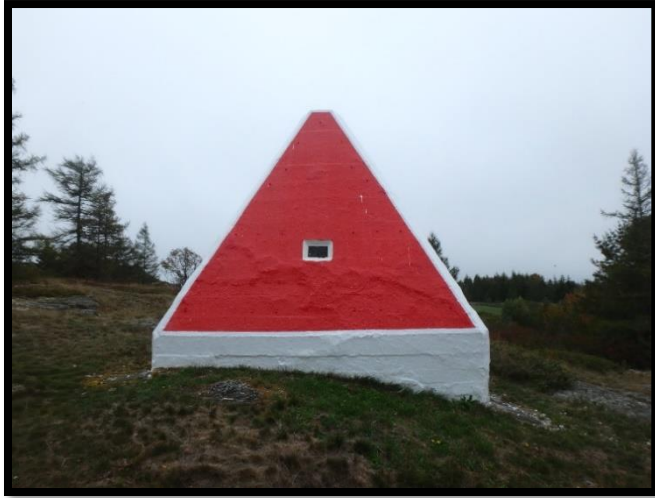
Figure 1- Repère d’alignement 8 située à Eastport, ME (ME/NB)
