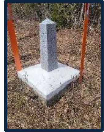
Signalisation installée pour protéger la borne des véhicules récréatifs. (ME/QC)
