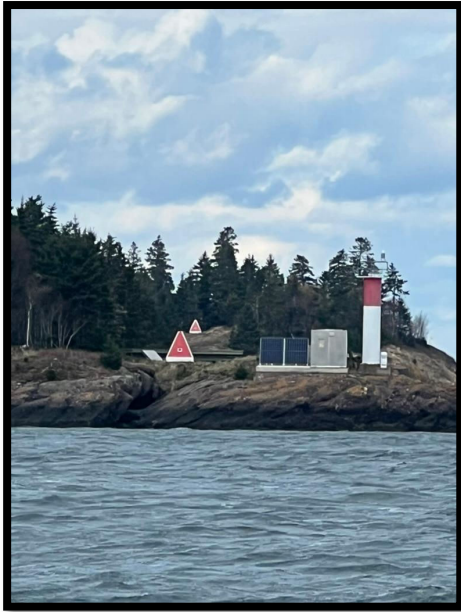
Les repères d'alignement 17 et 18 sur l'île Cherry dans la baie de Passamaquoddy sont utilisés pour localiser les points d'inflexion.
