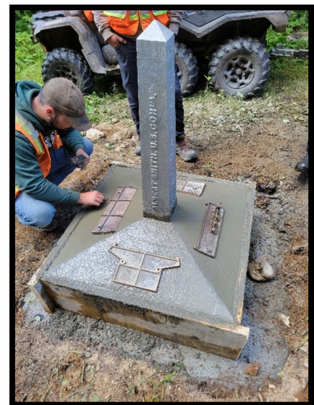
Marques d'identification placées lors de la prise du béton à la borne frontalière 226.
