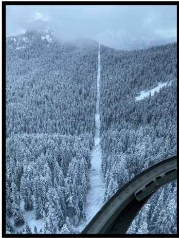
Inspection par hélicoptère des travaux de défrichage, le jour des premières neiges en montagne de l'année.
