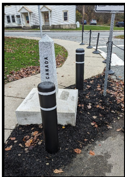
Borne 553AA ainsi que les deux bollards de protection nouvellement installés.
