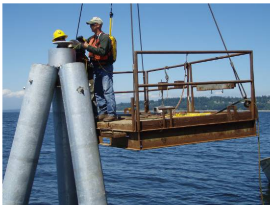
Kevin Bagwell vérifie le positionnement de la structure dans la baie Boundary
