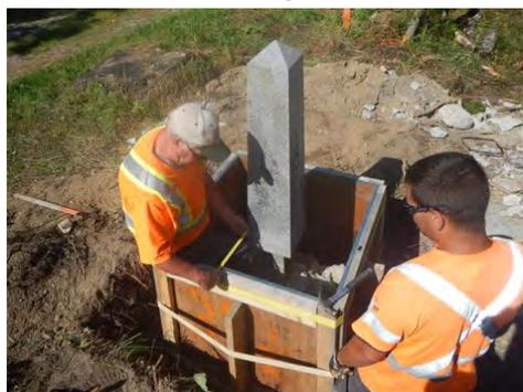
Figure 5 - Une borne en construction
